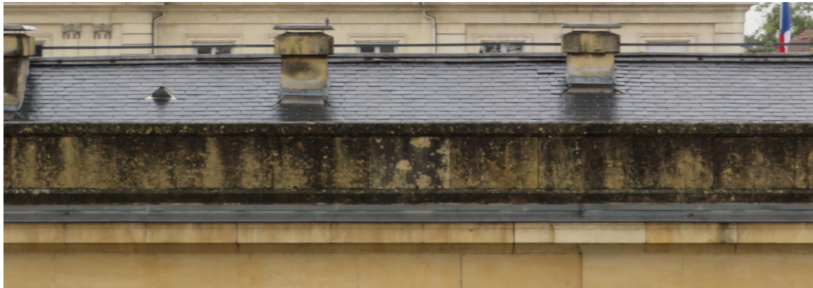
Figure 1. Colonisation biologique de l'attique. Aile ouest donnant sur la cour d'honneur.
